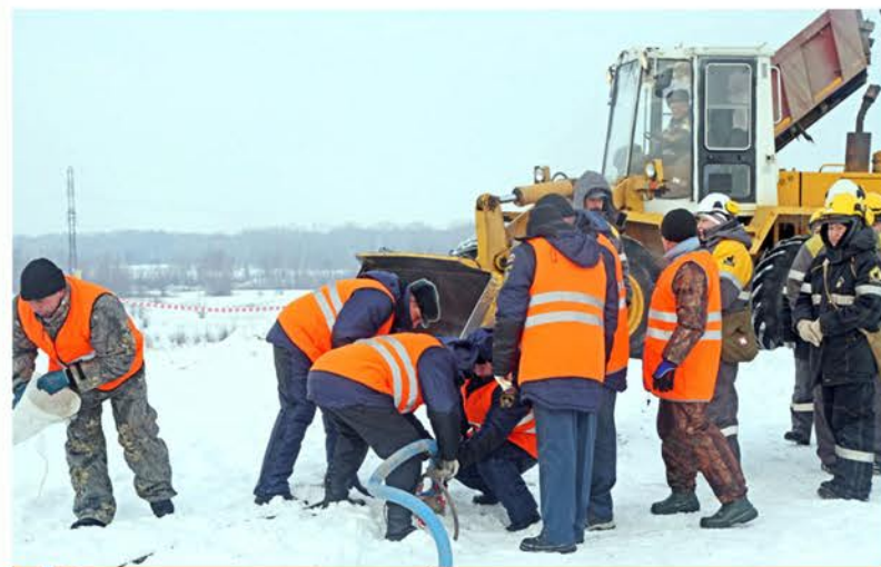
Подсоединение гидравлической помпы к станции
