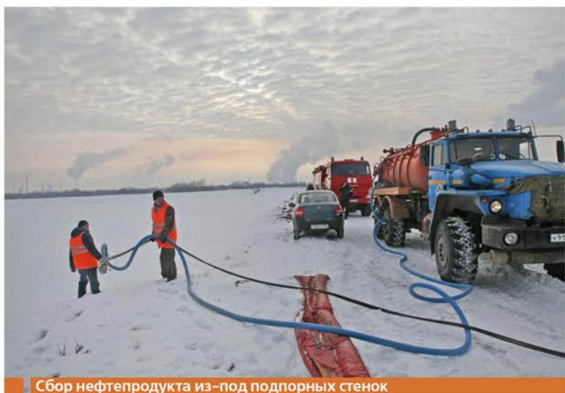
Сбор нефтепродукта из-под подпорных стенок
